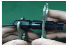
**Paso 4:** Compruebe la polaridad correcta del cable de conexión de los módulos FV y de los conectores de entrada FV. A continuación, conecte el polo positivo (+) del cable de conexión al polo positivo (+) del conector de entrada FV. Conecte el polo negativo (-) del cable de conexión al polo negativo (-) del conector de entrada FV.
